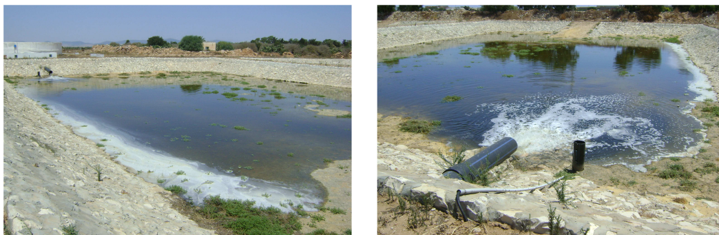
Fig. 3 – Imagens das bacias de infiltração da estação de Korba na Tunísia.
