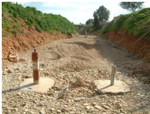
Fig. 22 – Leito do Rio Seco, Campina de Faro, Algarve
