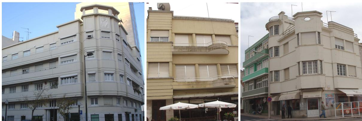
*Figura 5.11 – Exemplo de edifícios de «placa»; da esquerda para a direita: edifícios localizados em Lisboa, Alcobaca e Nazaré, respectivamente; classificados nos Censos 2001 como ACP; da esquerda para a direita: edifícios das classes 5 a 7 pavimentos, 4 pavimentos e 3 pavimentos, respectivamente; os edifícios no centro e à direita possuem R/C com espaço interior amplo na sua maior parte.*
