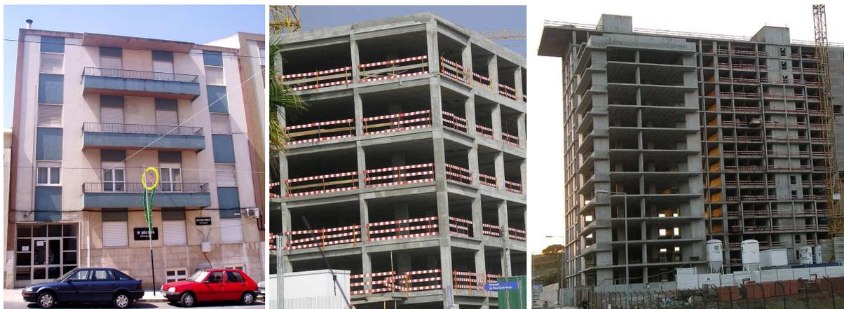
Figura 5.13 – Exemplo de edifícios de BA; esquerda: prédio da época 1961-70 localizado em Alcobaça; centro: estrutura em pórtico posterior a 2001, localizada em Lisboa; direita: estrutura mista pórtico parede, com lajes fungiformes, posterior a 2001, situada em Lisboa.
