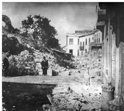
*As casas de alvenaria ou de tijolo cozido resistiram melhor, sendo nellas raro o desligamento das fachadas. [...] rachas verticaes profundas mostram que o desligamento esteve quasi a effectuar-se, mas os casos mais frequentes são os da queda parcial de um cunhal.*
