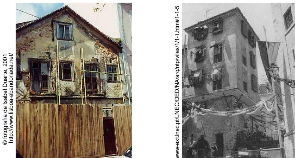
Figura 5.5 – Exemplo de edifícios pré-Pombalinos na cidade de Lisboa; esquerda: prédio de duas águas de fachada em bico; direita: prédio com ressalto bilateral; classificados nos Censos 2001 como ASP, anteriores a 1919.
