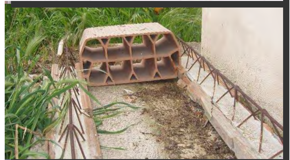
Pavimento com vigotas pré-fabricadas e abobadilhas
