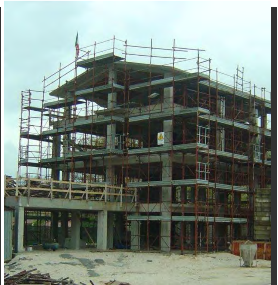
Edifício nos arredores de L'Aquila (em construção)
