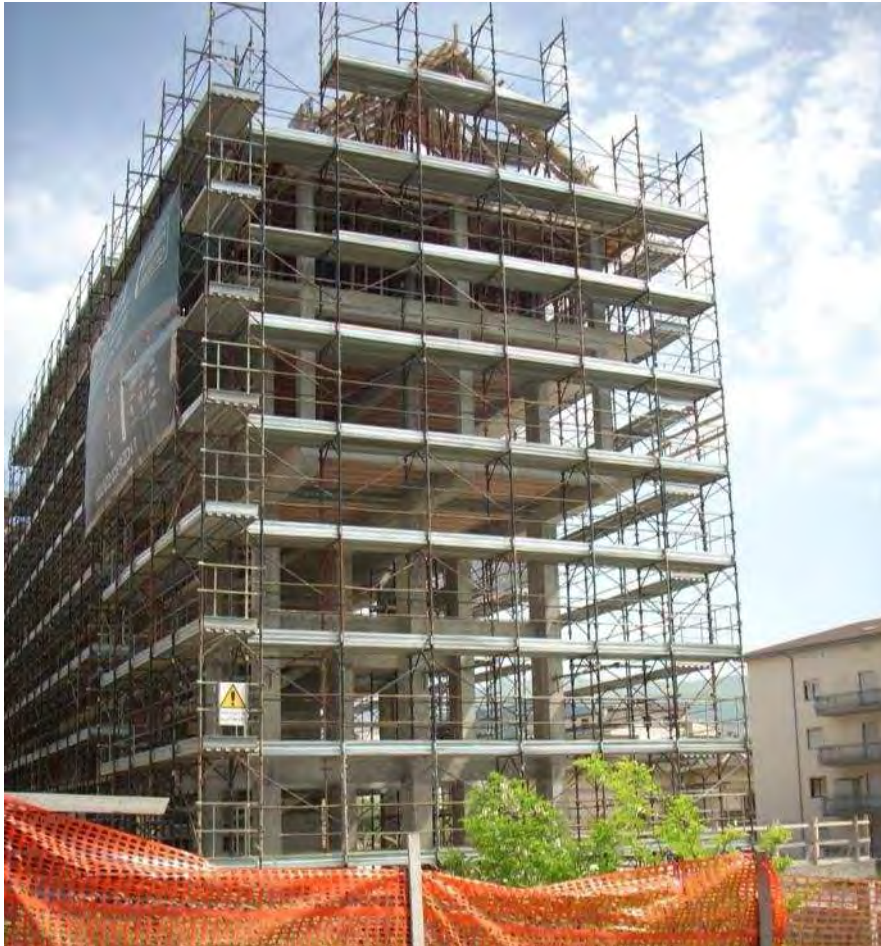
Edifício em construção nos arredores de L'Aquila, 2009-05-23
