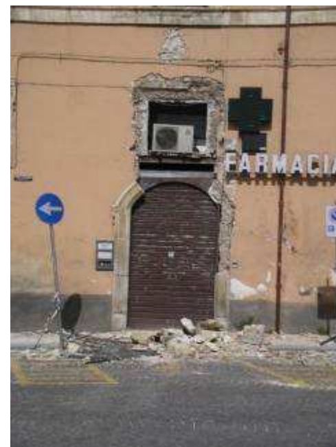
Danos por inserção de equipamentos
