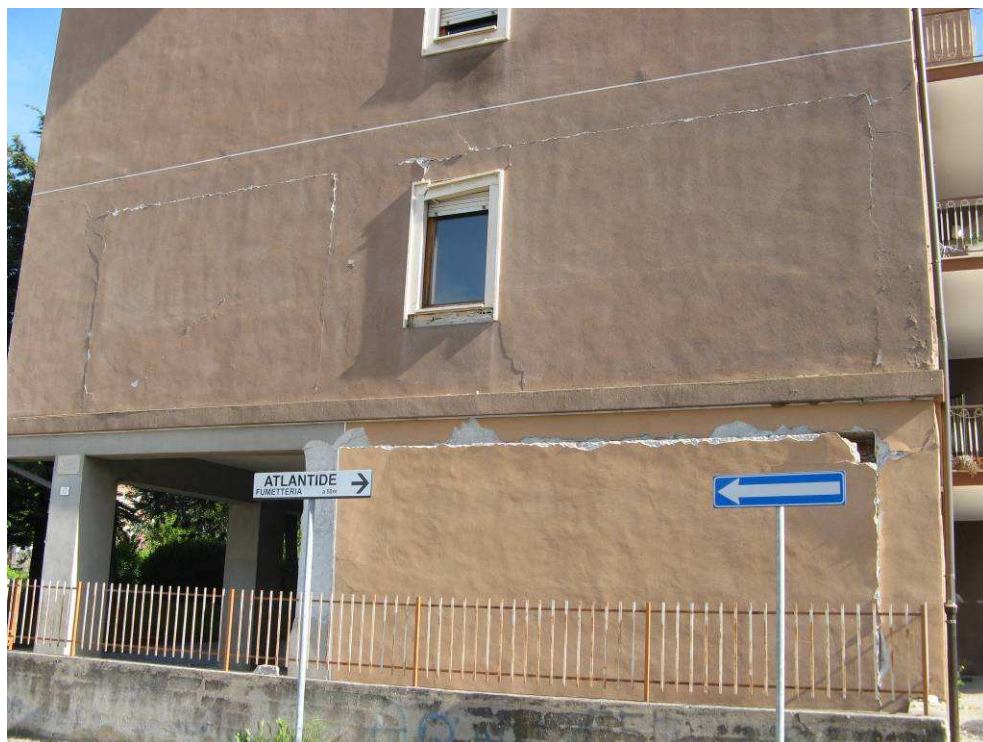
Mecanismo de rotura das alvenarias para fora do seu plano
