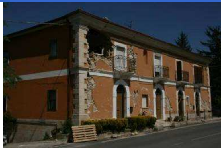
Danos por inserção de equipamentos
