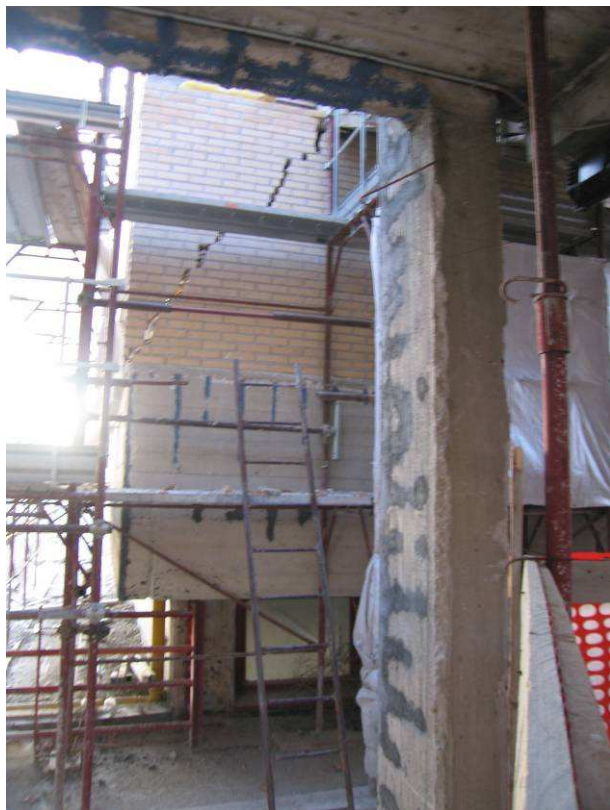
Fendilhação em paredes de alvenaria de fachada
