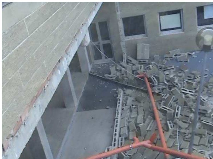
Edificio B, facciata principale, accesso al piano seminterrato (-1)
