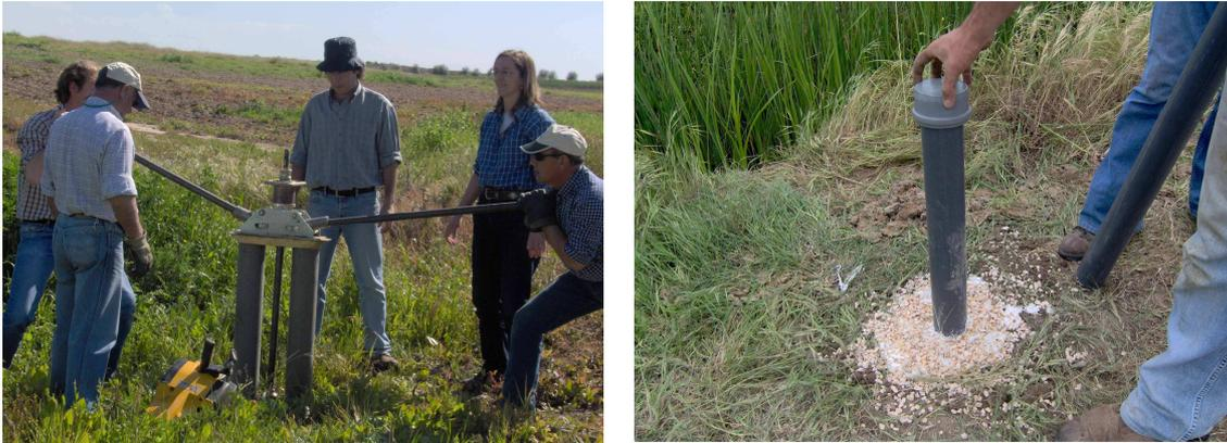
Fig. 13 - Instalação dos piezómetros
