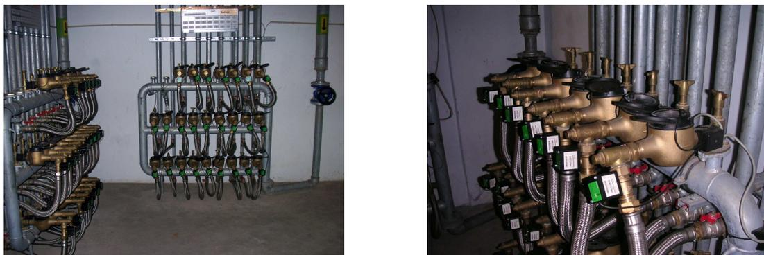
Figura 2 - Contadores instalados em bateria no complexo de edifícios Twin-Towers.
