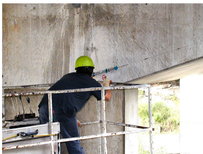
Figure 3 - Mesure des déformations par distancemétrie à fil Invar.
