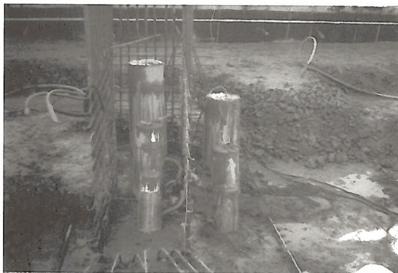
Fig. 3 – Colocação de um conjunto de células de fluência e respectivos dispositivos correctores na barragem do Alto Lindoso.
