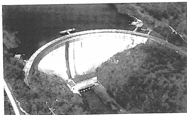
Figura 3 - Barragem do Cabril
