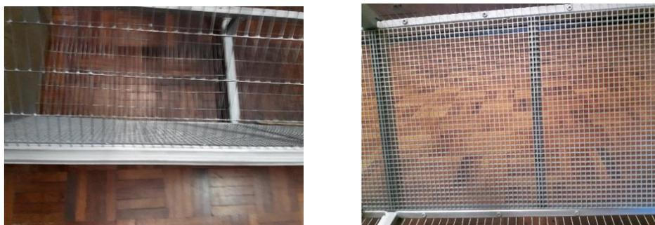
Fig. 5 | A longarina e a guarda, e o gradil do pavimento no modelo
