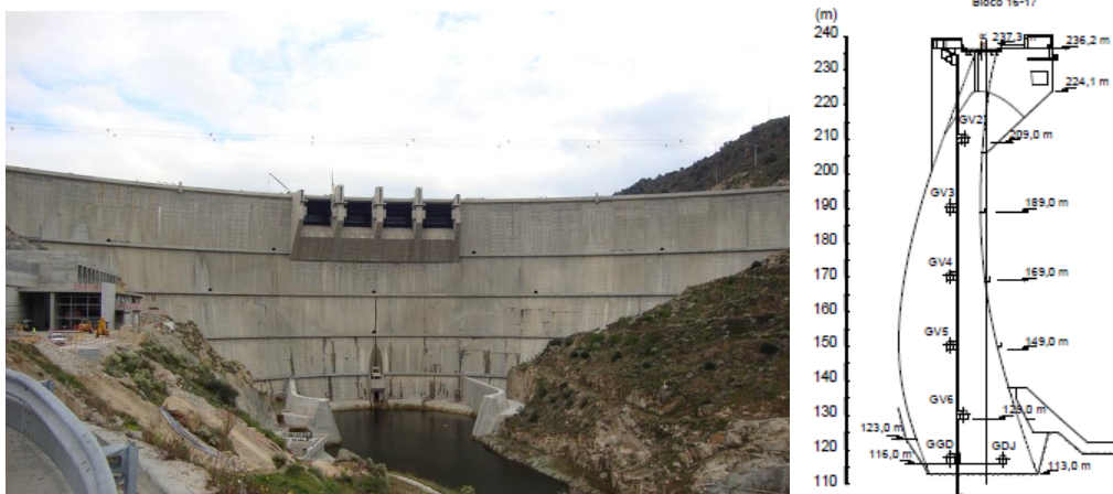
Fig. 3 - Vista de jusante da barragem do Baixo Sabor e corte vertical pela consola central
