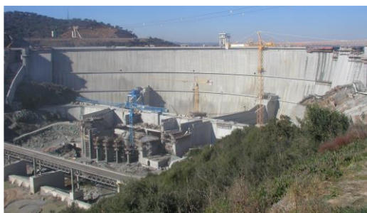
Fig 1 - Vista do paramento de jusante da barragem de Alqueva
