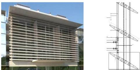
**Fig 1** - Dispositivo de sombreamento e esquema de montagem.
