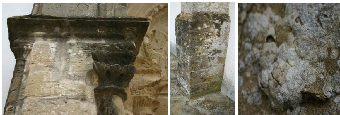
Fig. 8 – Colonização biológica – fungos (à esquerda e ao centro). Colonização biológica – líquenes (à direita)
