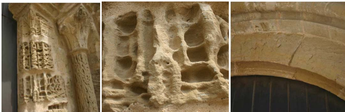
Fig. 7 – Formas de alveolização observadas nos portais da Igreja (à esq. e ao centro). Escamação nos blocos de arenito, na zona de fecho do arco do portal principal (à direita).
