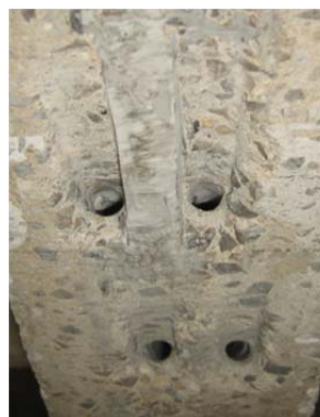
Fig. 2 - Processo construtivo da técnica CREatE (Chastre et al. 2016)
