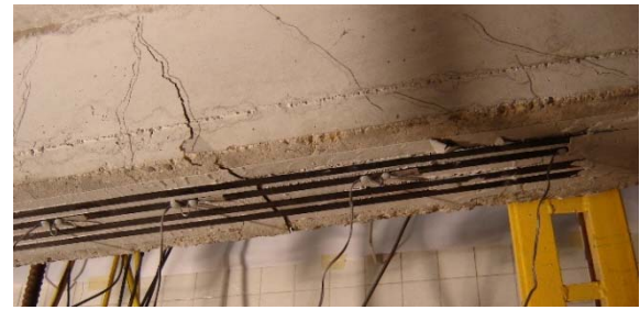
Fig. 8 – Pormenor próximo da zona de ancoragem dos laminados de CFRP da viga V8 (CREAtE), em que se detetam aberturas de fendas significativa sem que se verifique qualquer rotura prematura do sistema
