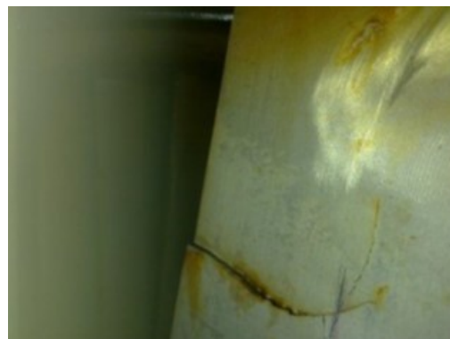
Fig 4 – Representação de uma das fissuras presente na região de trabalho de uma das pás.
