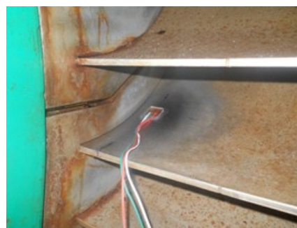
Fig 7 – Instalação de um dos extensómetros na pá do lado-terra.
