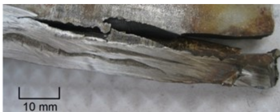
Fig 5 – Representação de uma das fissuras encontradas nas regiões de encastramento das pás.
