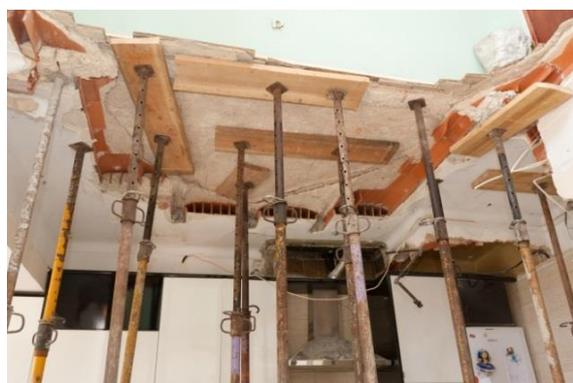
Fig. 8 - Escoramento da parede suspensa (e lâmina de compressão) da laje da cozinha do 3º andar dto.
