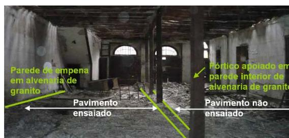
Fig. 2 – Esquema do pavimento ensaiado.
