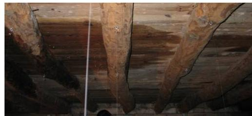
Fig. 7 – Ensaio 2, pavimento sem tarugos e com soalho.
