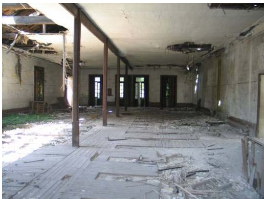
Fig. 5 – Compartimento A4 no piso 1
