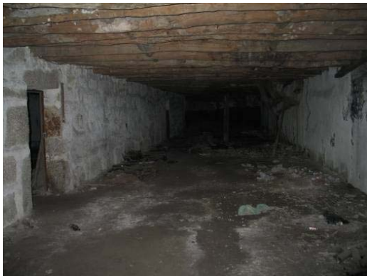
Fig. 4 – Compartimento A1 no piso -1
