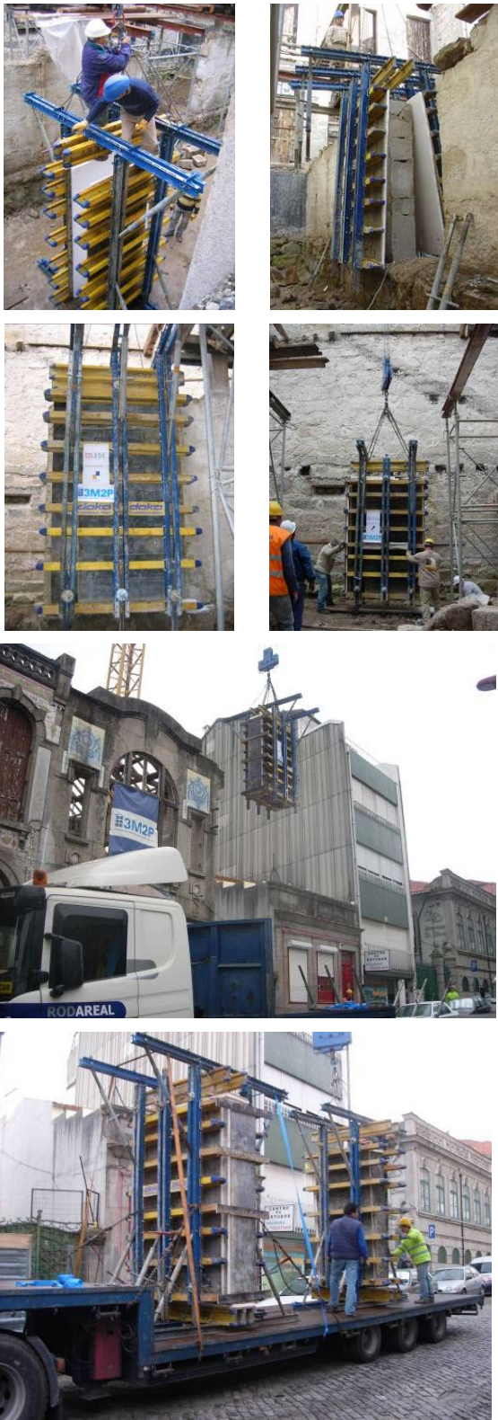
Fig. 15 – Extracção e transporte de troços de parede para o laboratório
