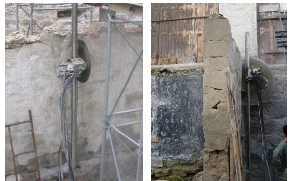
Fig. 14 – Corte de troços de parede em obra
