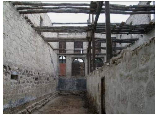
Fig. 6 – Interior do edifício após a retirada dos pavimentos e da cobertura
