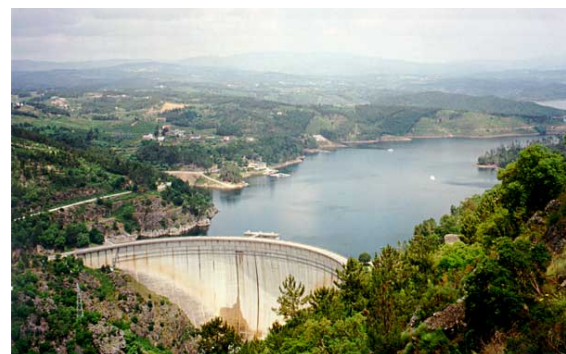
Fig. 2 – Vista da barragem do Cabril e da albufeira.
