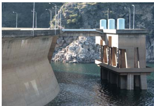
Fig. 4 – Vista lateral da barragem e da torre das tomadas de água com os órgãos de manobra das comportas.
