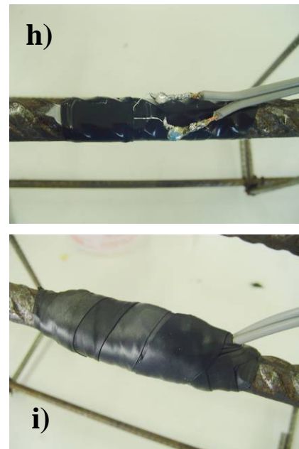
Fig. 11 – h) Ligação dos terminais; i) isolamento e proteção do strain-gage .
