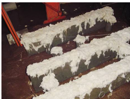
Fig. 6 – Cura das vigas por molhagem.
