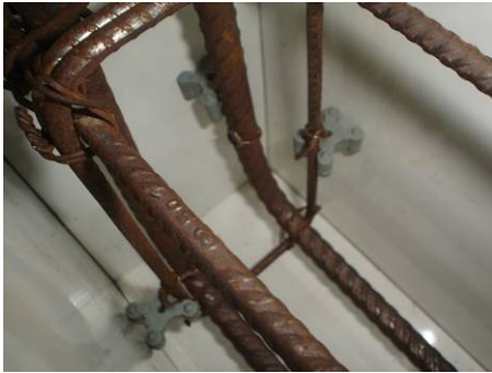
Fig. 5 – Detalhe dos espaçadores para garantia do cobrimento das armaduras.
