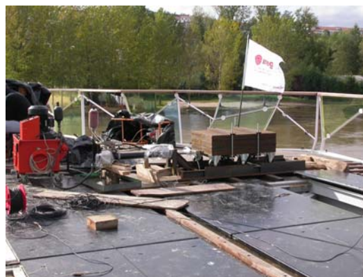
Fig. 1 – Excitador hidráulico na ponte Pedro e Inês
