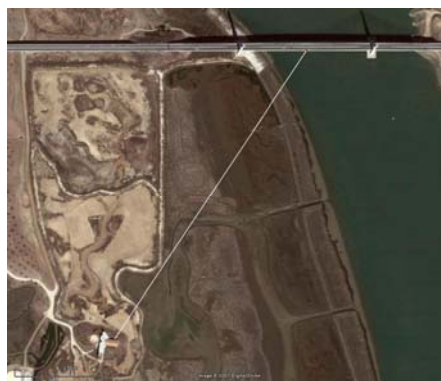
Fig. 11 – Aplicação de sistema de visão à monitorização dinâmica da ponte internacional sobre o rio Guadiana. Localização da câmara de vídeo
