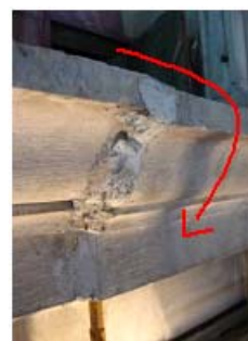
Fig 7 – Rotação dos elementos em consola
