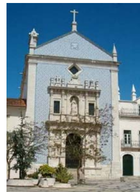
Fig 1 - Alçado principal da Igreja da Misericórdia de Aveiro
