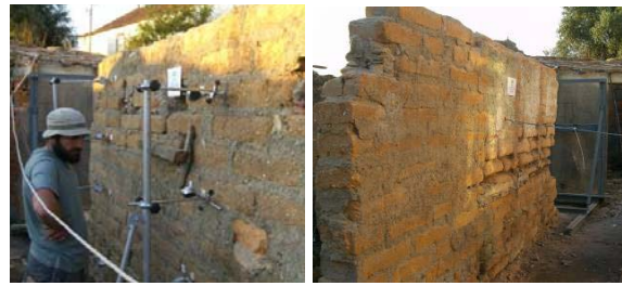
Fig. 18 – Ensaio da parede in-situ fora do plano: transdutores e aplicação da força horizontal.
