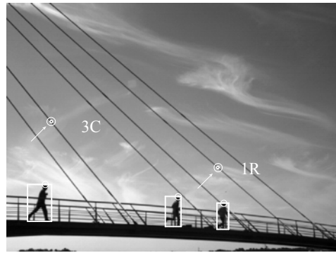
Fig 7 – Pontos analisados na ponte pedonal de Viana do Castelo.
