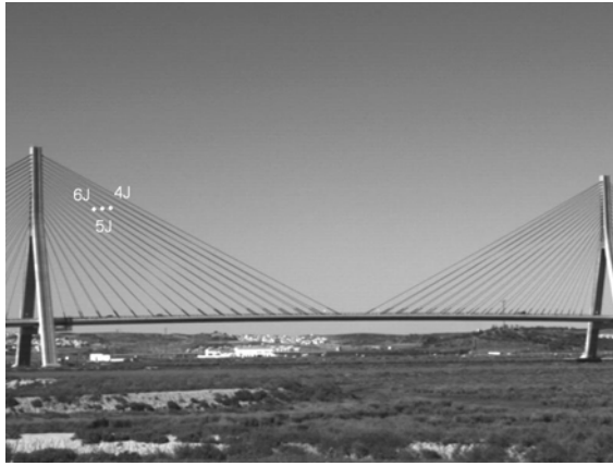
Fig 18 - Pontos analisados no segundo ensaio da Ponte Internacional do Guadiana.
