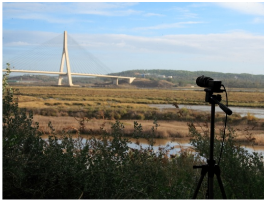
Fig 14 - Ponte do Guadiana, vista da ponte no local onde se recolheram imagens
